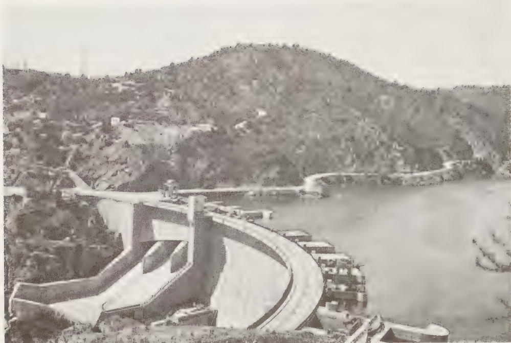
Figura Nº 232 Represa y planta hidroeléctrica de Rapel, obra de la ENDESA.
