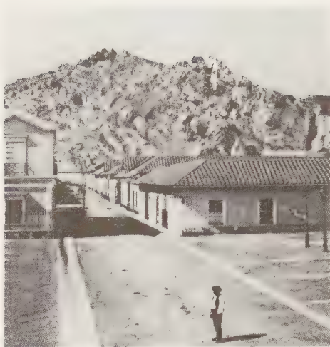
Figura N° 176 La transformación del Santa Lucía. El peñón rocoso antes de la acción de Vicuña Mackenna y un detalle después de los arreglos.
