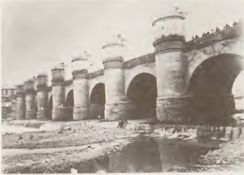
Figura N° 88 El Puente de Cal y Canto.
