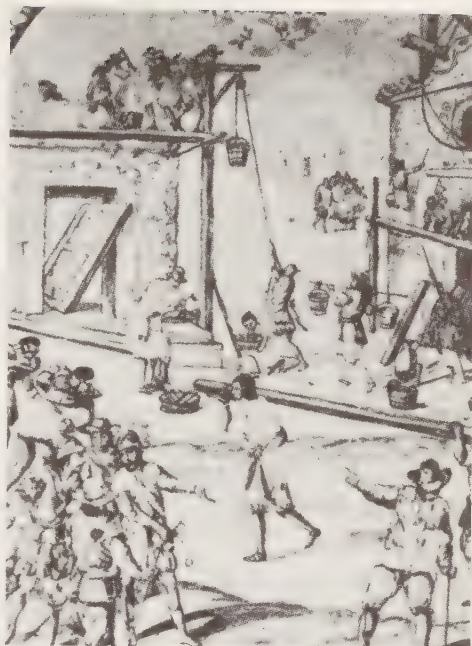
Figura Nº 70 Indígenas mexicanos trabajando en una construcción.
