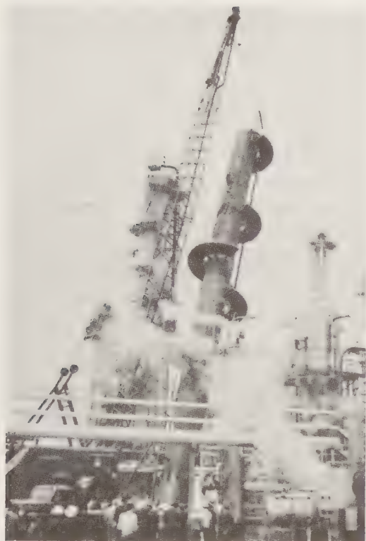
Figura N° 233 Construcción de la refinería de petróleo de Concón.
