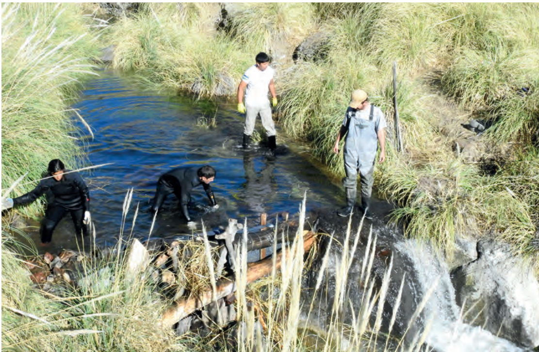
■ Reforzamiento de salto preexistente en la Rama Fría del arroyo Valcheta para impedir el avance de los peces invasores (mojarra plateada y trucha arcoíris) hacia la naciente, mayo de 2019. Foto: Rodrigo Calvo.
