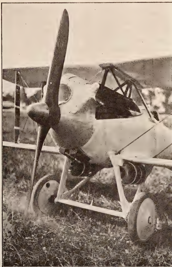
Le NIEUPORT à moteur HISPANO-SUIZA 300 HP.
