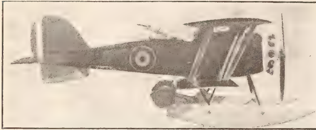
L'avion amphibie SAGE n° 10. Les roues d'atterrissage sont rabattues vers l'arrière.
