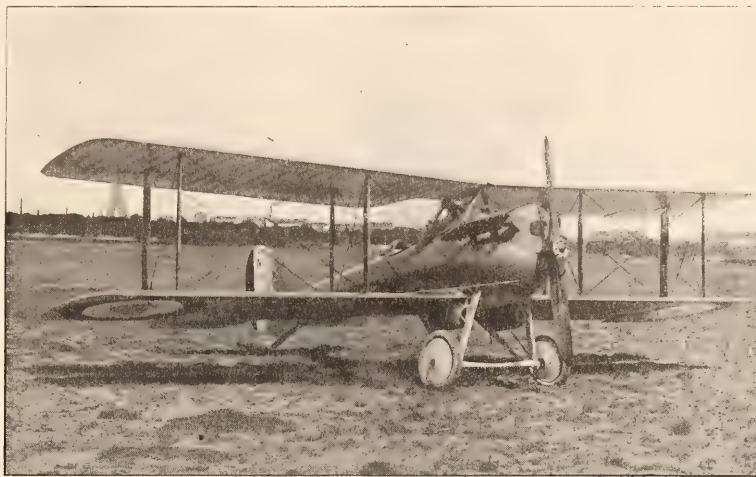
L'avion NIEUPOINT type 29 C-1, monoplace militaire à deux mitrailleuses.
