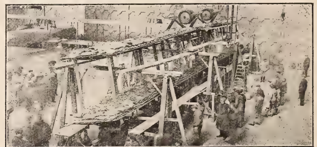
Essais statiques du CAUDRON BIMOTEUR C-23.
