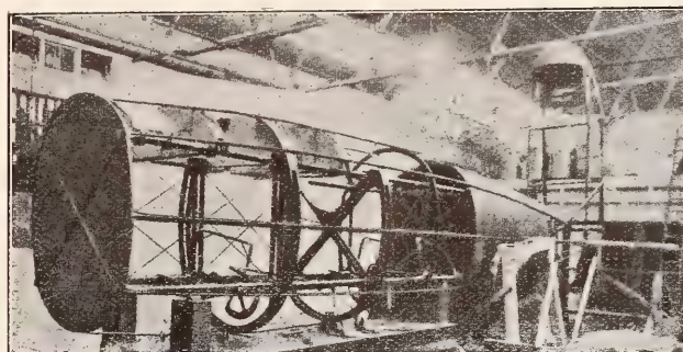
La construction métallique. Fuselage du Boulton and Paul n° 10.
