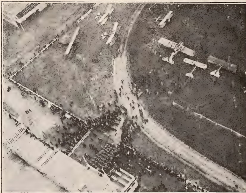
L'arrivée de M. Millerand, vue d'avion.
