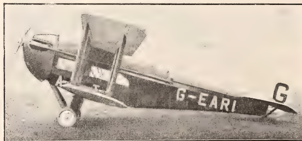
L'AVION D. H 18 (450 HP. NAPIER-LION), mis en service sur la ligne Paris-Londres. L'avion emporte huit passagers, ou une tonne de fret.
