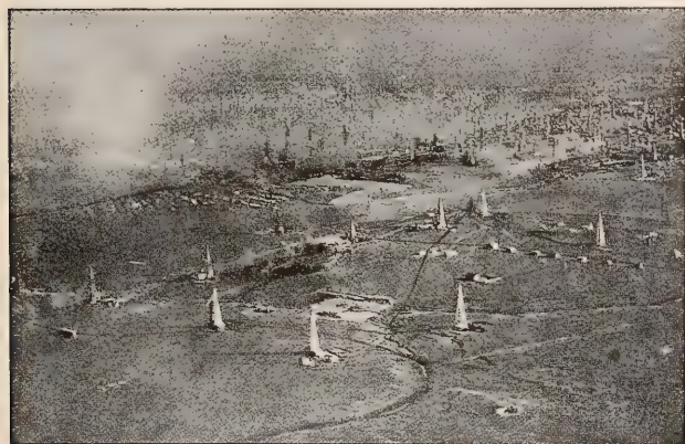
Photographie aérienne d'exploitation pétrolière aux États-Unis.
